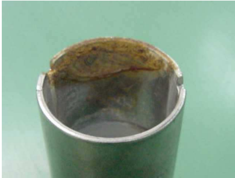
Corrosão na armadura
