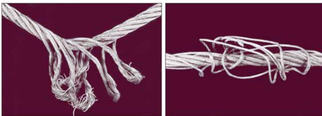
Figura 385 - Deformações de cabos de aço por excesso de carga Fonte: do Autor
